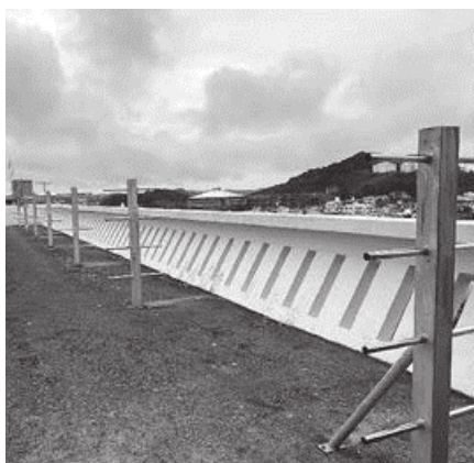
緋会館 屋上糸引き場
