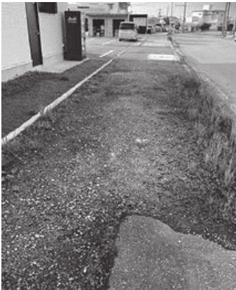
町道290号線 歩道現状
