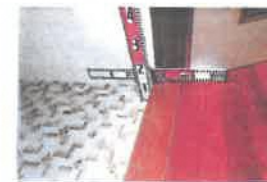
工事前 トイレ段差写真
