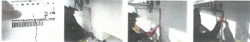
①ひび割れ0.5mm以上 ②Vカット処理 ③シーリング充填 ④フィラー仕上げ
