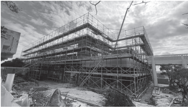
令和6年1月の工事の状況
