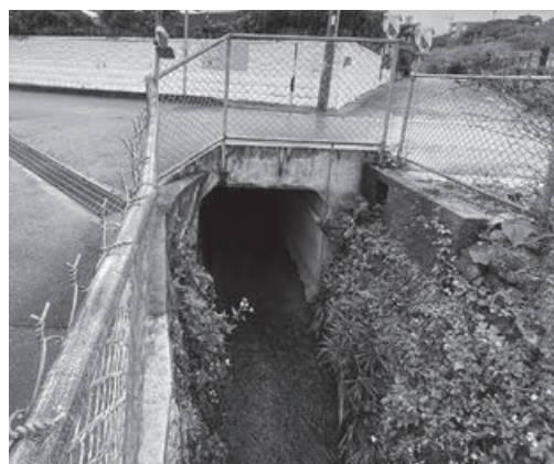
暗渠になり住宅地を通る水路
