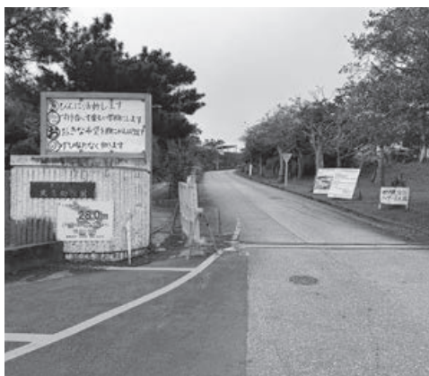
正門の狭い通路（改良前）
