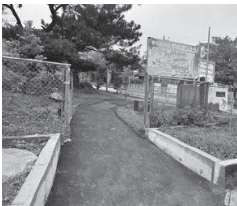
改良後の正門横の通路（改良後）
