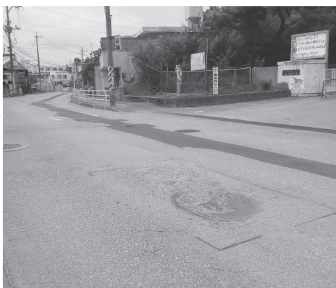
町道3号線の現状
