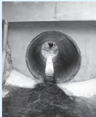
工事後の様子
