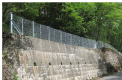
<落石防止柵の取替>
