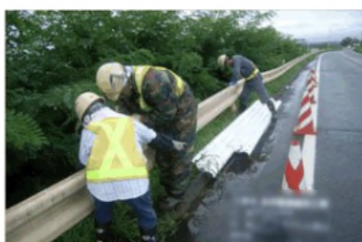
<防護柵の取替>
