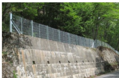
<落石防止柵の取替>
