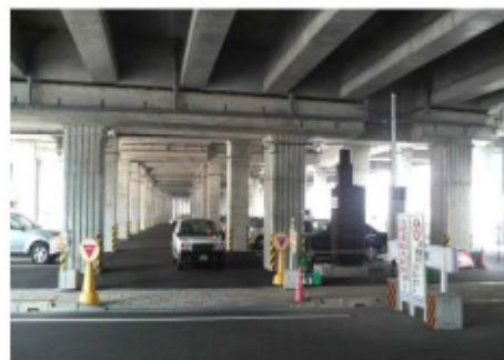
高架下を利用したタクシープール
