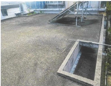
省エネ工事・耐久性(屋根遮熱・防水) 施工前
