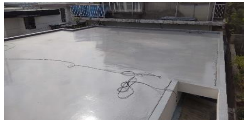
省エネ工事・耐久性(屋根遮熱・防水) 施工後
