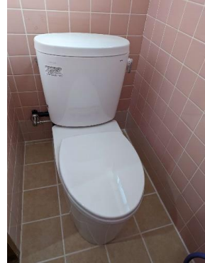
バリアフリー改修工事(和式→洋式) 施工後
