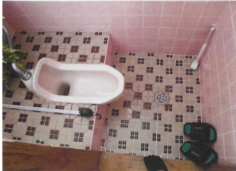
バリアフリー改修工事(和式→洋式) 施工前
