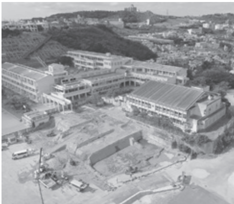
北丘小体育館工事現場
