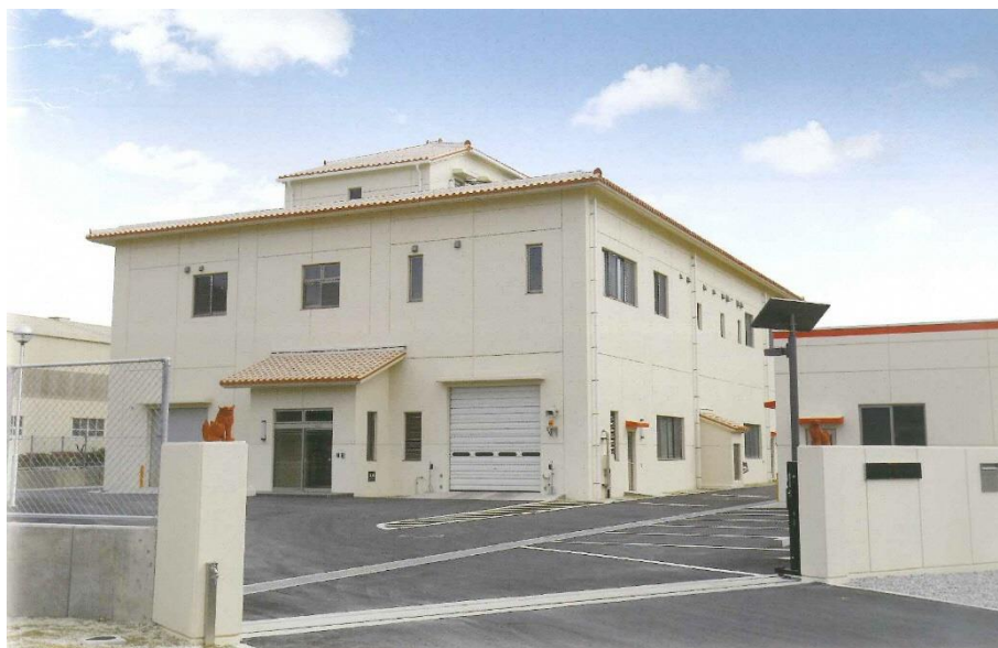
写真：南部広域行政組合汚泥再生処理センターパンフレット 写真 3.1 汚泥再生処理センター
