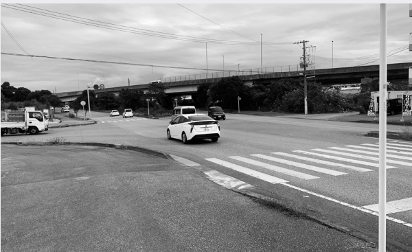
信号機の要請箇所（南インターから徳洲会向け）
