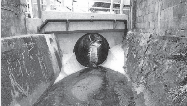
5月に完成した照屋橋
