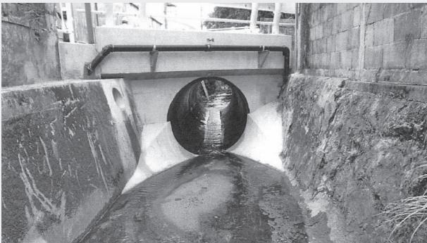
5月に完成した照屋橋
