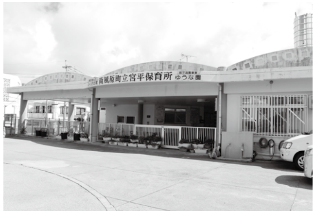
▲保育士不足により一時保育を行えない状況である。
