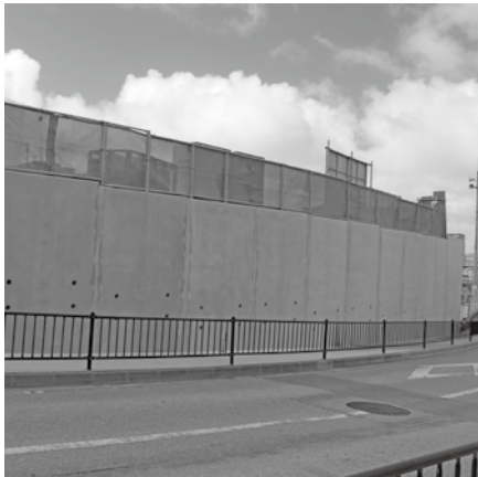
▲第一団地の擁壁
