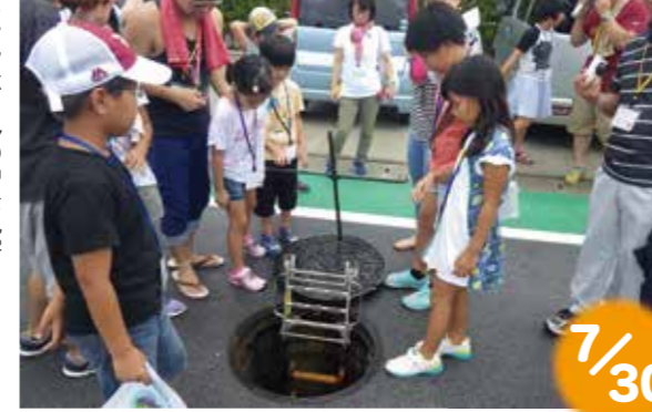
マンホールの中を見学
