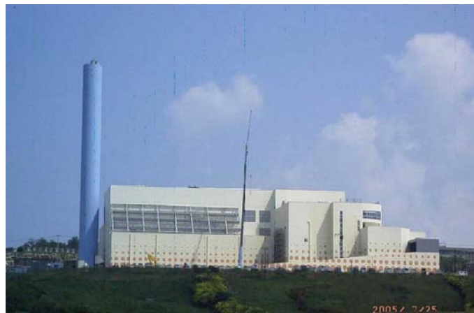
平成18年4月より本格稼働した那覇・南風原クリーンセンター
