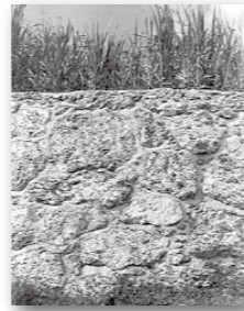
穴埋めされた石積み
