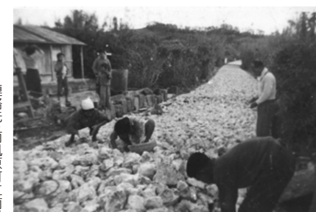
共同作業での道路整備(字宮平)
