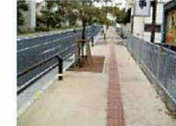
・歩道（透水性舗装）
