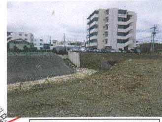
津嘉山1412番地周辺 工事中
