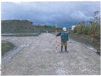
津嘉山553番地周辺 工事中
