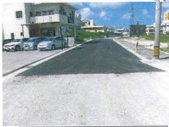
津嘉山1461番地周辺 工事完了
