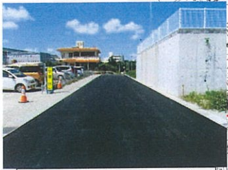
津嘉山1464番地周辺 工事完了
