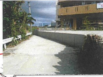
津嘉山1316番地周辺 工事完了
