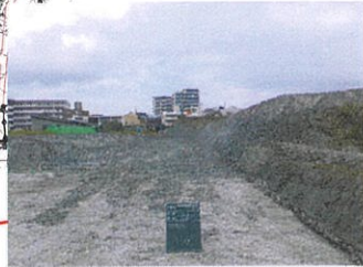
津嘉山486番地周辺 工事中
