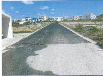
津嘉山1452番地周辺 工事完了
