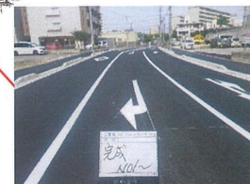
区画道路12-1 工事完了
