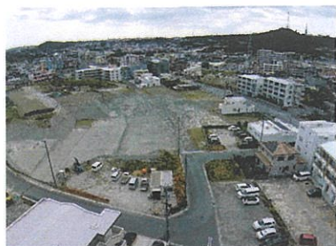
旧津嘉山ハイツ周辺 造成工事中
