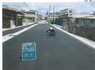
津嘉山585番地周辺 工事完了
