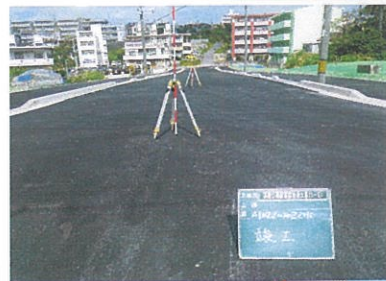
本部公園線 工事完了
