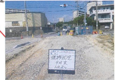
区画道路12-1 施工中
