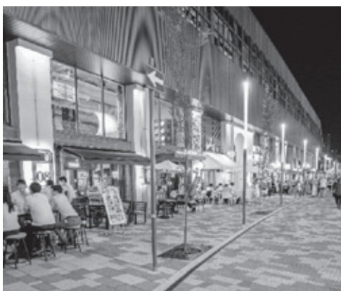
高架下店舗リニューアル後の神戸市サンキタ通り
