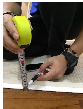
バリアフリー改修工事(浴室入口段差解消) 施工後
