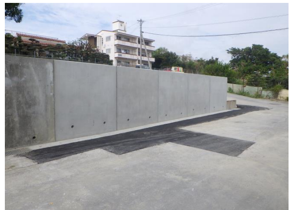
●津嘉山1393番地周辺 工事完了
