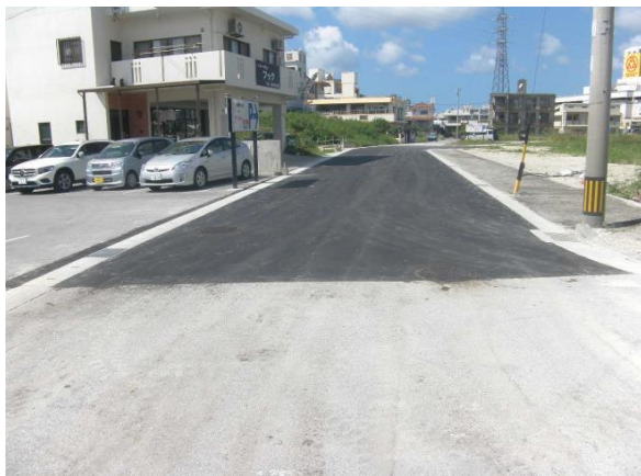
●津嘉山1461番地周辺 工事完了
