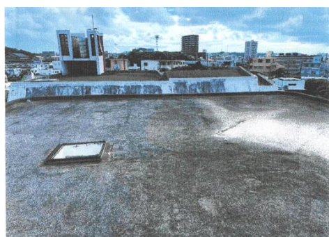
省エネ改修工事(屋根断熱) 施工前
