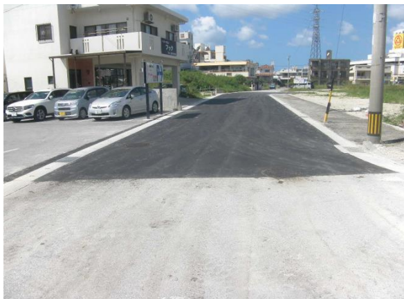
●津嘉山1461番地周辺 工事完了
