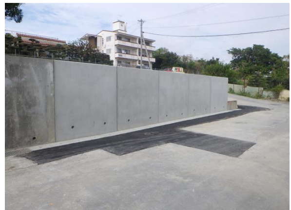
●津嘉山1393番地周辺 工事完了
