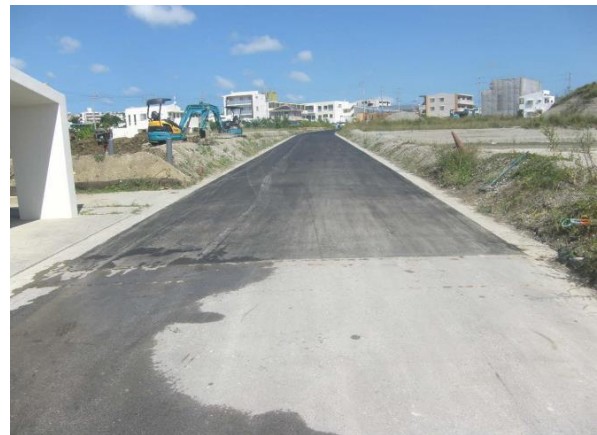
●津嘉山1452番地周辺 工事完了
