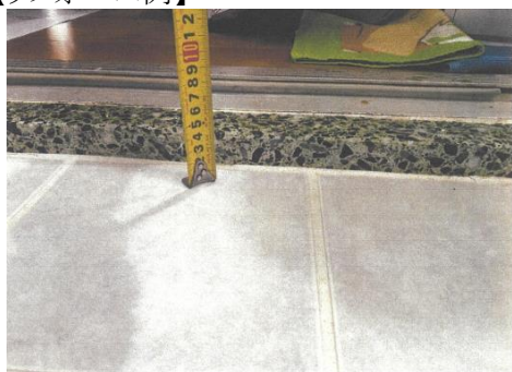
バリアフリー改修工事(浴室入口段差解消) 施工前
