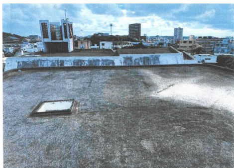
省エネ改修工事(屋根断熱) 施工前
