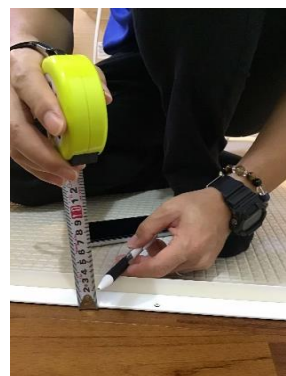
バリアフリー改修工事(浴室入口段差解消) 施工後
