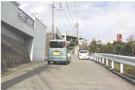
①住宅地内で通過交通が多く、歩道のない道路(町道 47 号線)
