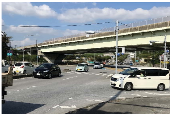
①交通事故が多い交差点(南インターチェンジ付近)
