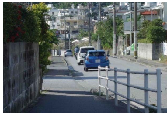
⑥ガードレールが未整備の通学路(町道 3 号線)
