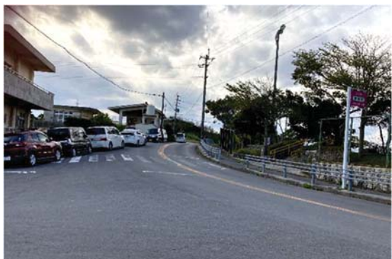
⑤駐車場が不足している神里ふれあい公園
