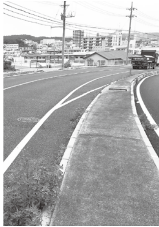
急がれるガードレール設置箇所
