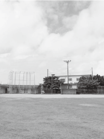
完成から32年経過している山川体育センター
