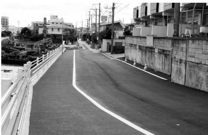
町道11号線の現在の様子。河川側は歩道としてカラー舗装されています。
