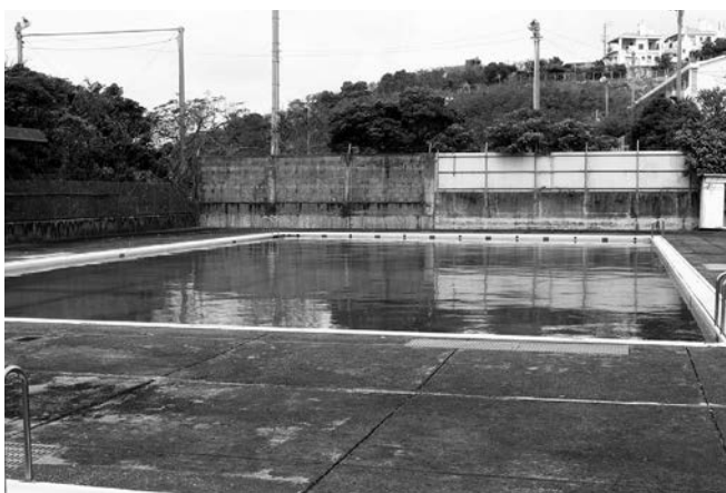
北丘小学校プールの現状
