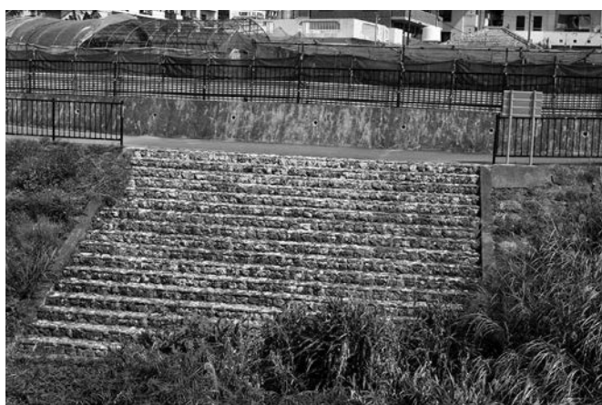
石原橋近くのスロープ（兼城）
