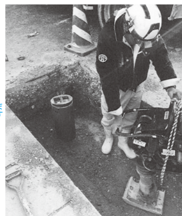
枅設置工事写真
