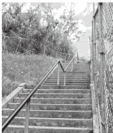
北丘小西側通路の現状
