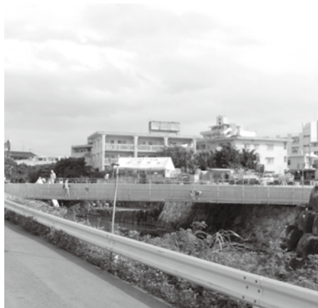
改修工事中の平原橋（宮平）
