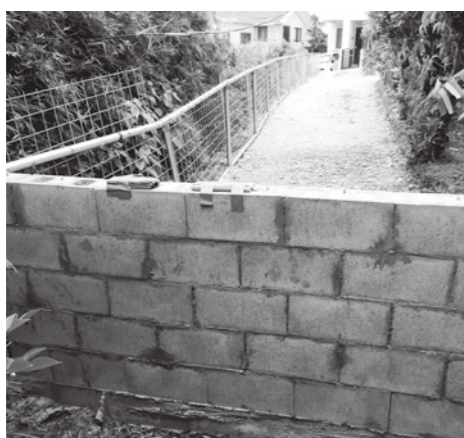
里道に積まれたブロック塀
