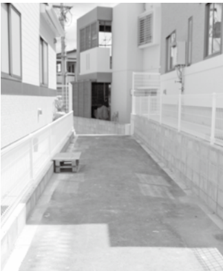
2m幅員の避難通路
