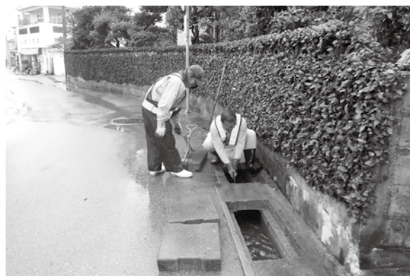
側溝の清掃作業
