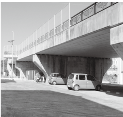
津嘉山大橋桁下の状況
