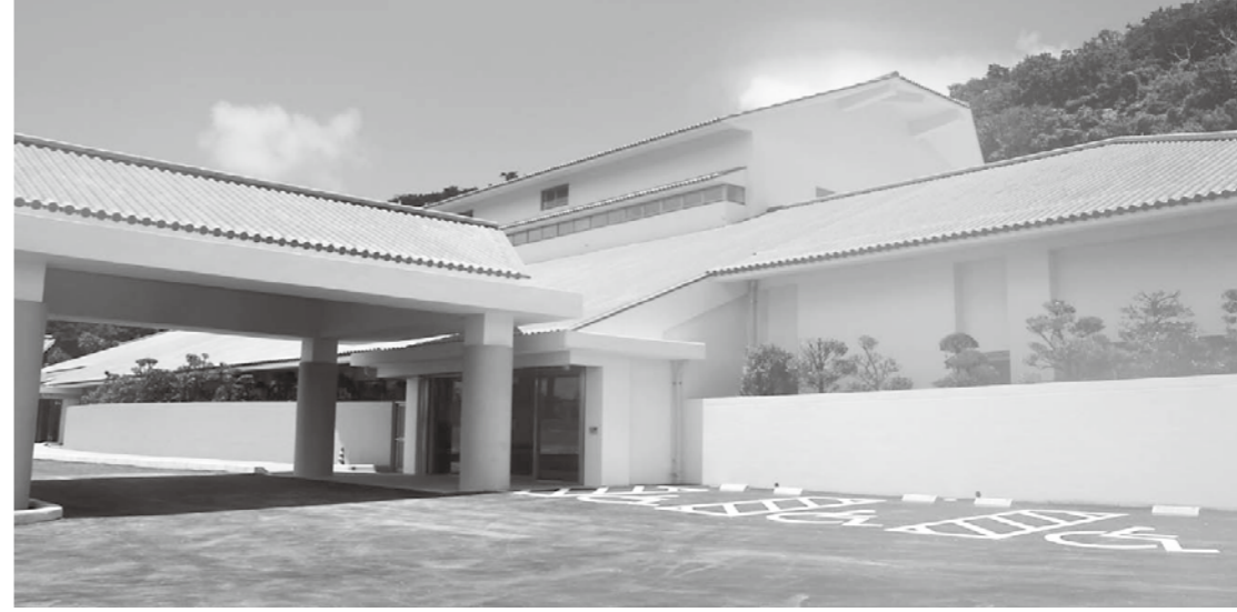
平成26年6月26日に供用開始された南斎場
