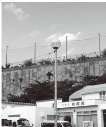
北丘小学校運動場南側の擁壁
