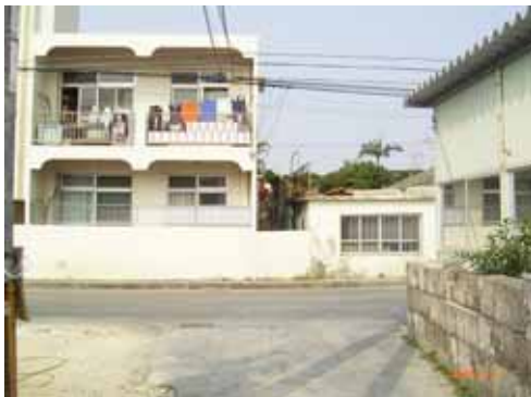
工事着工前 (道路反射鏡設置工事)
