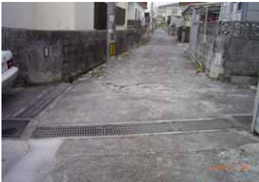
本部地区の工事着工前
