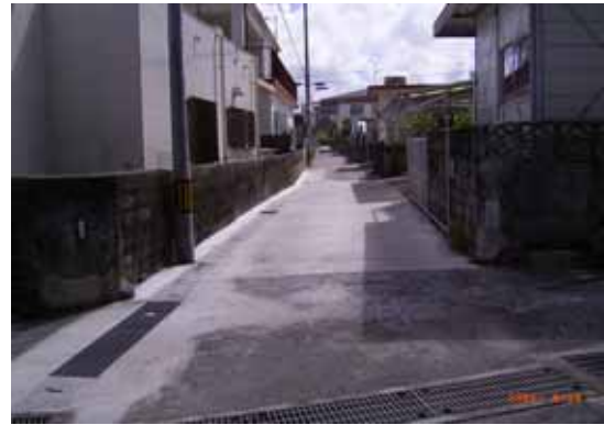
本部地区の工事完了後
