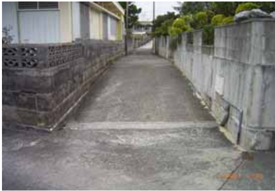
津嘉山地区の工事着工前
