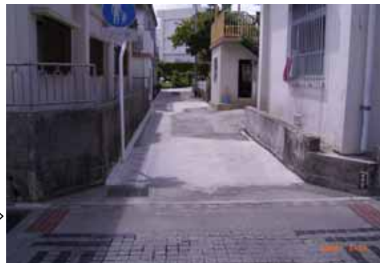
喜屋武地区の工事完了後
