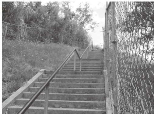
北丘小学校の新川階段を整備します
