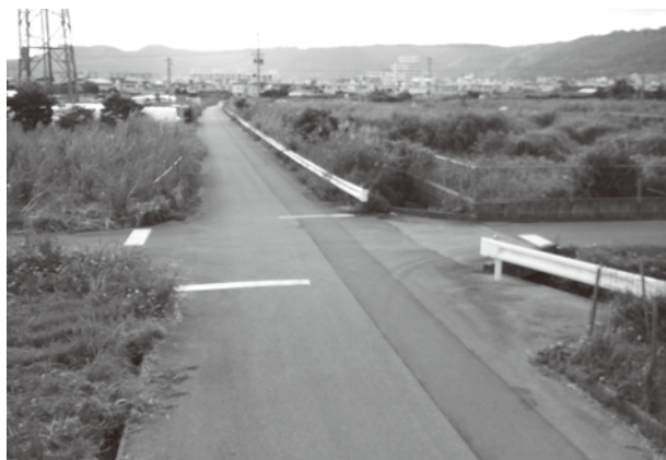
南城市土地改良区の停止線
