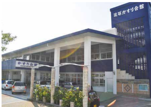
全面改築された琉球かすり会館の外観
