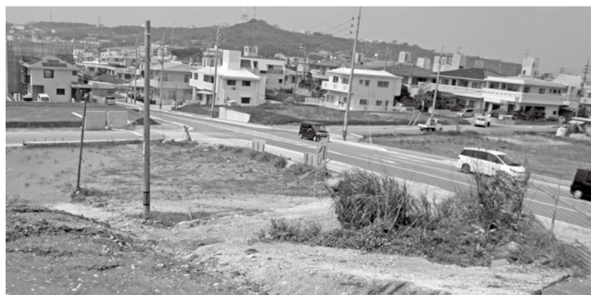
津嘉山中央線街路区域は徐々に整備されているが、未整備で危険な交差点も多い。
