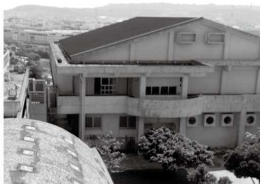
北丘小学校の体育館
